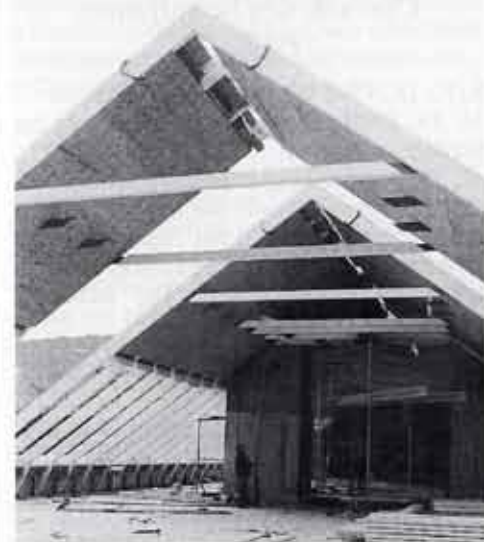
Bauarbeiten am Dach der neuen Schule
