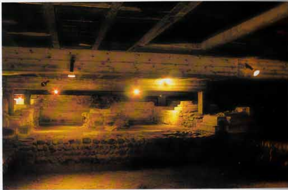
Romanische Klosterkirche Mehrerau Blick von Westen in den Chorraum Foto: Becking
